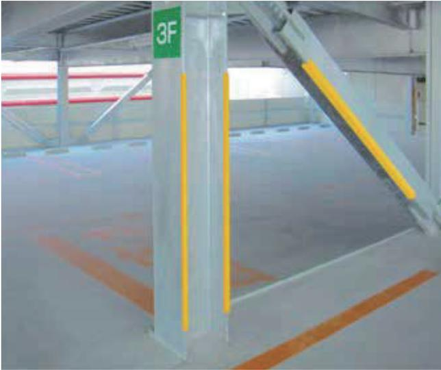
むき出した危険なH鋼の端部をソフトにカバーして、美観よく安全にします。
